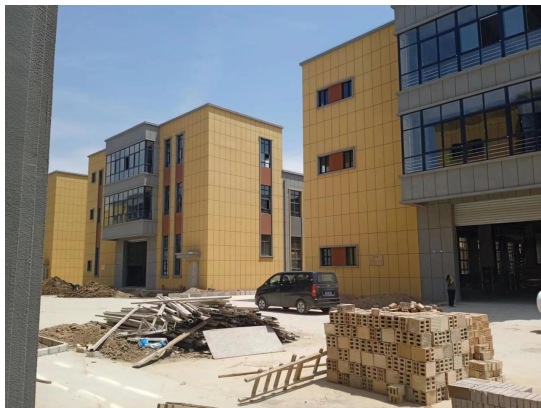
项目西侧-空厂房
