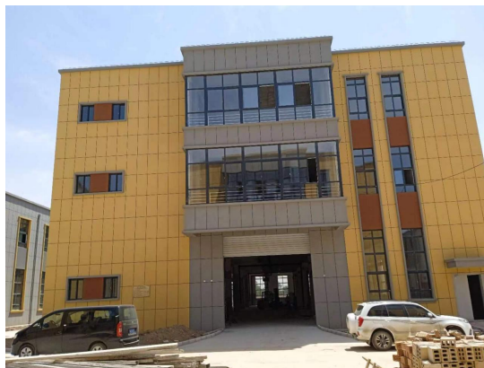
项目现状-空厂房
