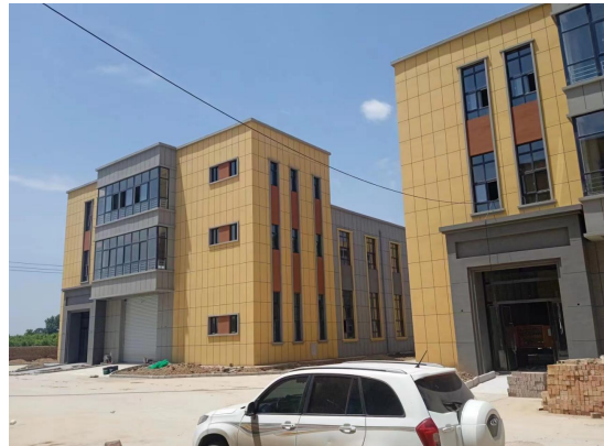
项目南侧-西安市天工机械密封有限公司
